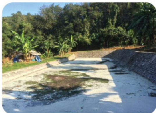
ก่อนปรับปรุง
